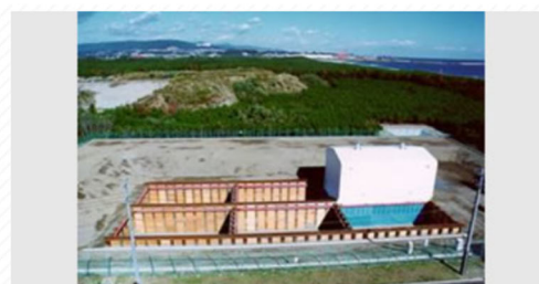
廃棄物埋設用トレンチ外観及び雨水浸入防止用テント（定置開始前）
