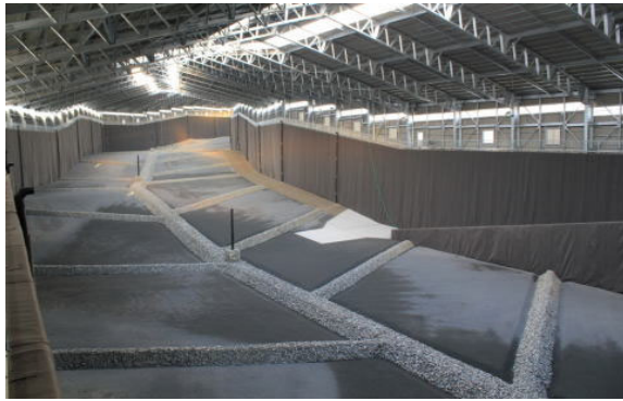
(a)被覆施設内、底部遮水設備敷設状況
