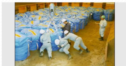
フレキシブルコンテナ収納廃棄物の定置作業状況
